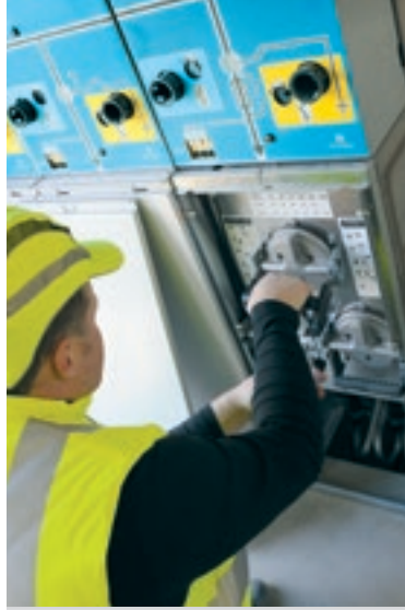
Remplacement d'un fusible
