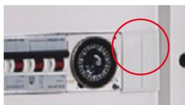
Jeu de 3 pièces d'un module et de 2 d'un 1/2 module.
