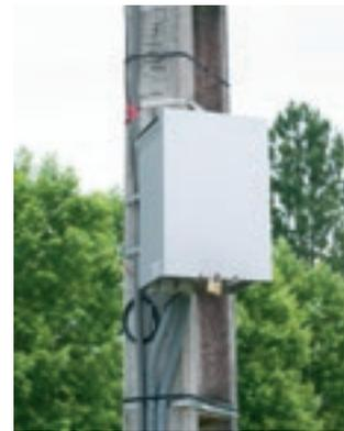
**Les coffrets IControl-T s'adaptent sur tous types de support : poteaux bois, béton ou métallique.**
