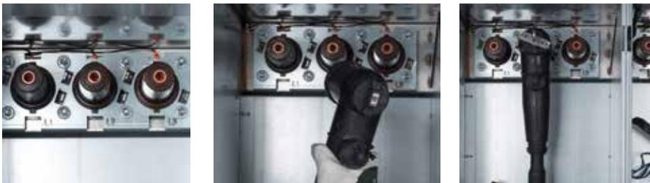
Exemple de raccordement via un connecteur séparable droit CSE (PME) 250 A sur cellule Interrupteurs Fusibles (IFA) :
