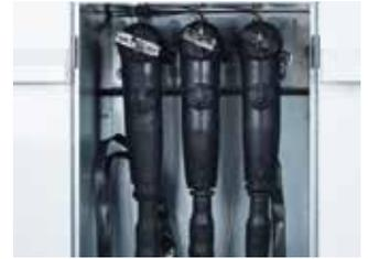
Raccordement MT, sur cellule Arrivée Interrupteur (AI)
