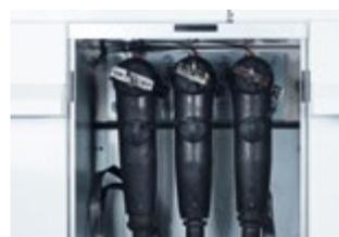
Raccordement MT sur cellule Arrivée Interrupteur
