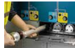
Remplacement fusibles
