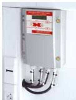
Détecteur de défauts directionnels
