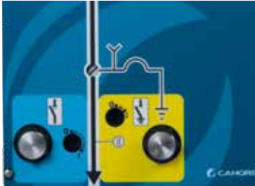
Mécanisme commande Tumbler motorisé
