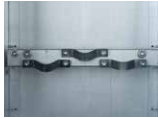
Serre-câbles sur cellule AI ou IFA
