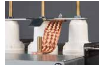
Prises d'injection de tension sur AI
