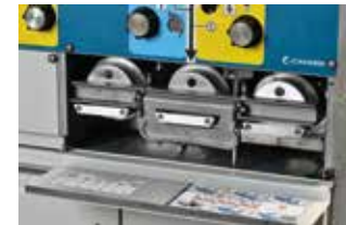
3 puits fusibles sur IFA
