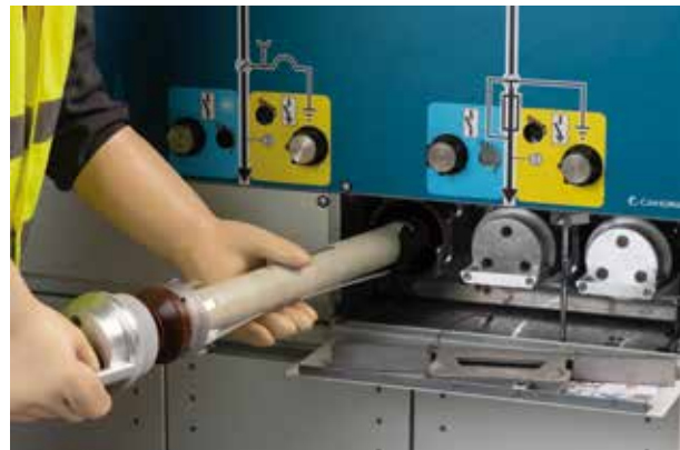
Remplacement d'un fusible
