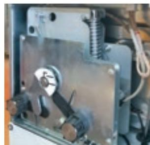
Mécanisme commande Tumbler motorisé sur cellules AI
