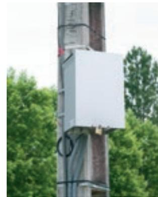
**Les coffrets IControl-T s'adaptent sur tous types de support : poteaux en bois, béton ou métallique.**
