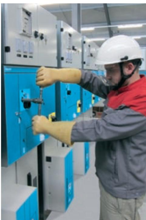
Manœuvre d'un interrupteur
