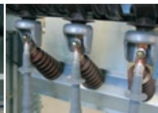
Raccordement câbles MT avec extrémité EUIC
