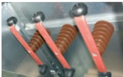
Raccordement câbles MT avec extrémité EUIC
