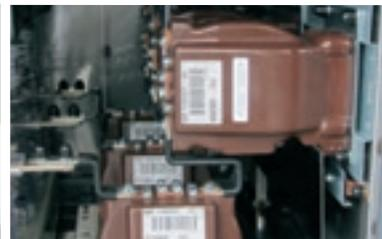
Transformateur de courant double enroulement secondaire
