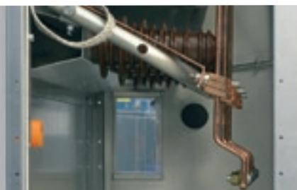
Plage de raccordement pour câbles MT avec extrémité EUIC
