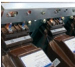
Transformateur de courant double enroulement secondaire
