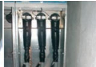
Raccordement MT sur cellule DDC
