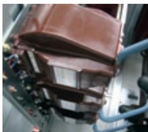
Transformateur de courant double enroulement secondaire
