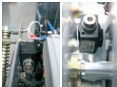
Déclencheur d'ouverture avec bobine à émission 230 Vca
