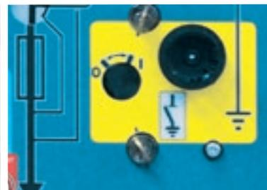
Serrures pour verrouillage HT/BT/TR via les clés de sécurité
