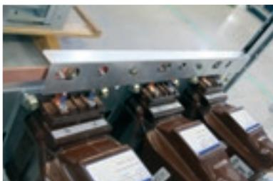
Transformateur de courant double enroulement secondaire
