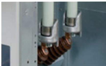
Raccordement câbles MT avec extrémité EUIC
