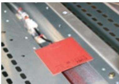
Résistance de chauffage et d'anti condensation
