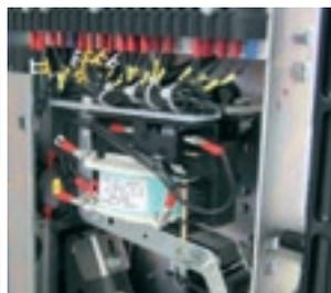
Déclencheur d'ouverture avec bobine à émission
