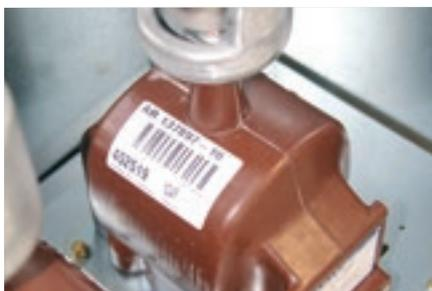
Transformateur de tension double enroulement secondaire
