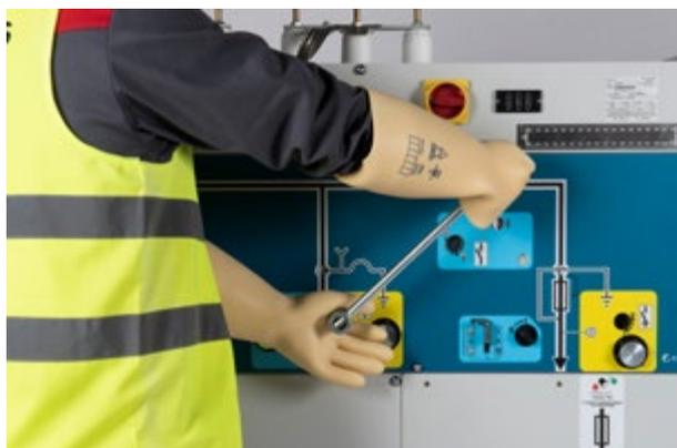
Manœuvre d'un sectionneur
