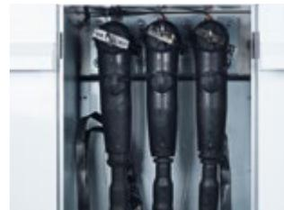
Raccordement MT sur cellule Arrivée Interrupteur (AI)
