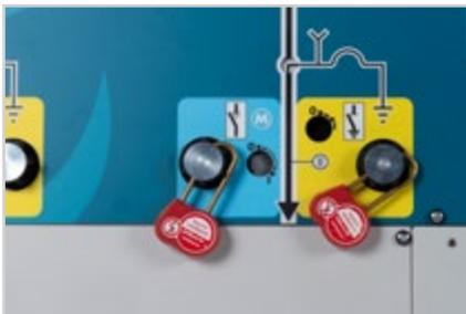
Obturateur verrouillable de l'arbre de manœuvre (à l'aide d'un cadenas)
