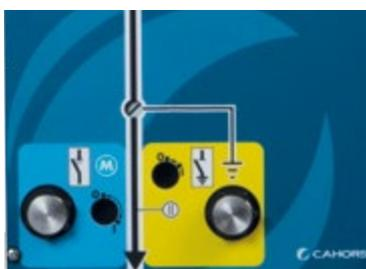
Mécanisme commande Tumbler motorisé C 13-200
