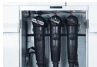
Raccordement MT sur cellule Arrivée Interrupteur
