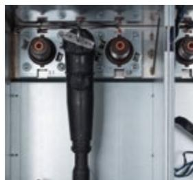
Exemple de raccordement via un connecteur séparable droit CSE (PME) 250 A sur cellule Interrupteurs Fusibles (IFC) :
