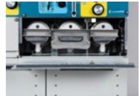
3 puits fusibles sur IFC
