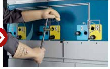
**ÉTAPE 3 :** fermer le sectionneur de mise à la terre afin de libérer le verrouillage du compartiment fusibles
