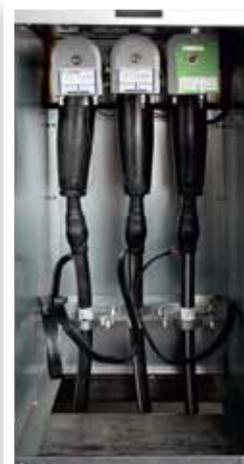
Capteurs de tension électroniques sur connecteur séparable équerre
