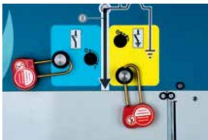
Obturbateur verrouillable de l'arbre de manœuvre (à l'aide d'un cadenas)
