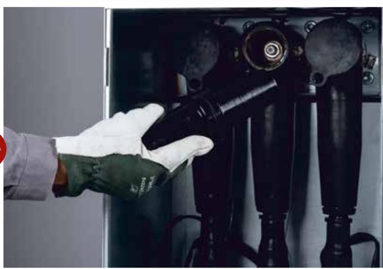
ÉTAPE 2 : retirer la partie arrière du connecteur séparables équerre et placer les adaptateurs
