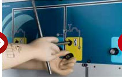
**ÉTAPE 2 :** placer la manivelle sur le l'arbre de manœuvre du sectionneur de mise à la terre
