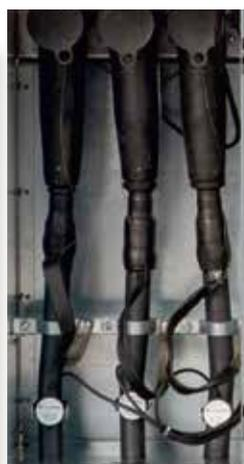
Compartment câbles AI avec tore de courant ouvrant
