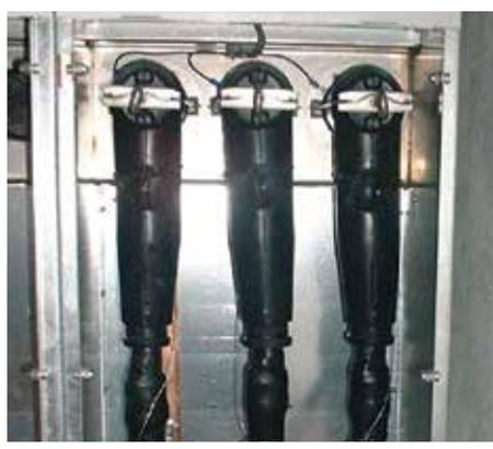
Chaque câble doit en moyenne dépasser de la fosse de 700 mm (mesure prise verticalement en partant de chaque connecteur MT) pour être facilement raccordé.
