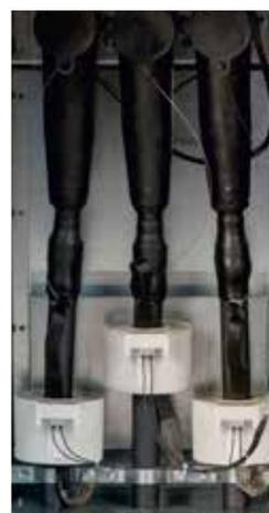
Compartment câbles DPT avec tore de courant fermé de protection
