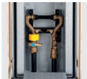
Robinet avant compteur verrouillable Pe 25 - sans caloduc
