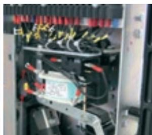
Déclencheur d'ouverture avec bobine à émission et contact de position disjoncteur
