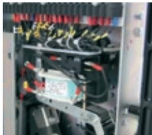
Déclencheur d'ouverture avec bobine à émission
