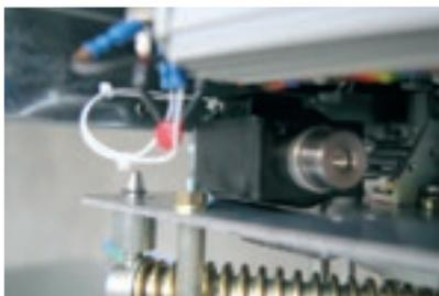
Déclencheur d'ouverture avec bobine à émission 230 Vca
