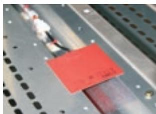
Résistance de chauffage et d'anti condensation
