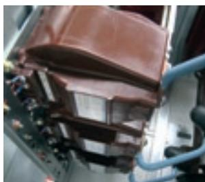
Transformateur de courant double enroulement secondaire
