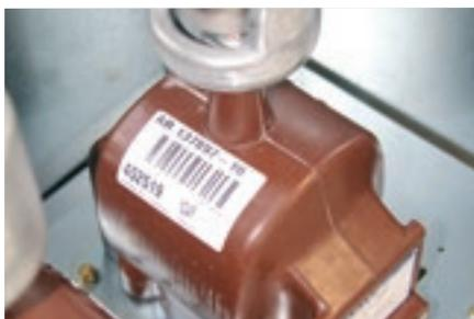
Transformateur de tension double enroulement secondaire
