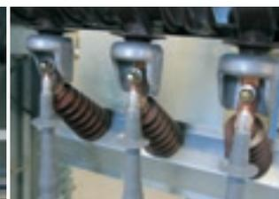
Raccordement câbles MT avec extrémité EUIC
