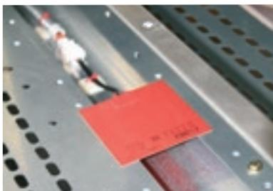
Résistance de chauffage et d'anti condensation
