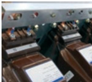
Transformateur de courant double enroulement secondaire
