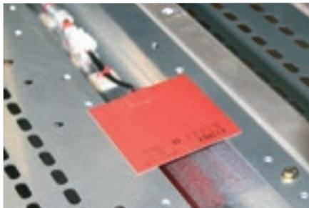
Résistance de chauffage et d'anti condensation
