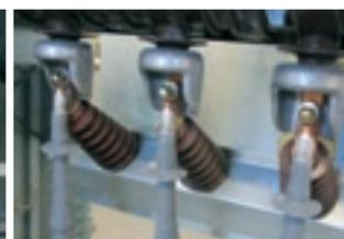
Raccordement câbles MT avec extrémité EUIC
