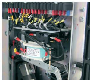
Déclencheur d'ouverture avec bobine à émission
