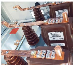
Transformateur de courant double enroulement secondaire
