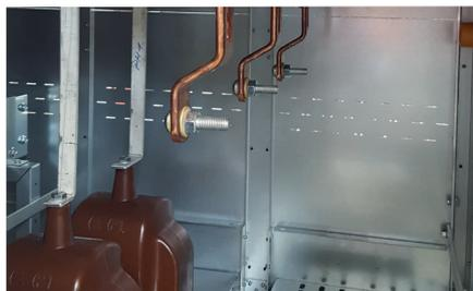
Plage de raccordement pour câbles MT avec extrémité EUIC
