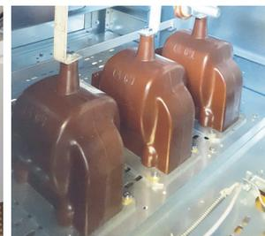
Transformateurs de tension double enroulement secondaire
