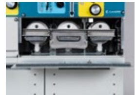
3 puits fusibles sur IFC
