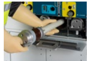
Remplacement fusibles
