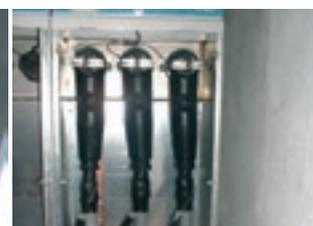
Raccordement MT sur cellule Arrivée Interrupteur
