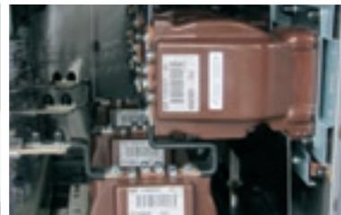
Transformateur de courant double enroulement secondaire
