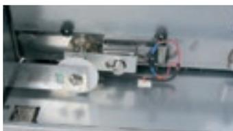
Verrouillage disjoncteur / sectionneur
