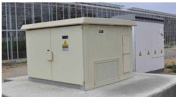
Postes élévateurs destinés aux applications Energies Renouvelables et stockage d'énergie. Raccordés en antenne, en coupure d'artère ou en fausse-coupure à partir d'un réseau MT privé, ces postes servent à transformer, distribuer l'énergie produite et à protéger l'exploitation ou le réseau
