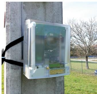
**Detectores de defectos direccionales y amperimétricos para red aérea de tensión mediana.**
