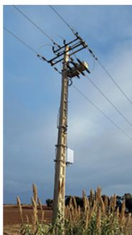
Interruptor-seccionador de tensión mediana aislado en el SF6 con corte en carga manual o bien telecontrolado hasta 36 kV. Instalación en red aérea.
