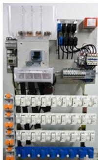
Tableaux Basse Tension pour postes souterrains permettant de distribuer et protéger le réseau BT.
