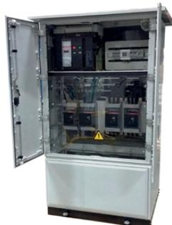
Cuadros de baja tensión para estaciones subterráneas que permiten distribuir y proteger a la red de BT mediante aparatos de tipo disyuntor (CEI-947-2).
