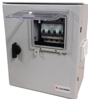
Caja o placa para auxiliares de estaciones subterráneas que permiten gestionar por separado la alimentación y la protección de las funciones auxiliares de una estación de distribución.
