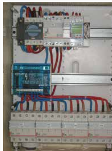
Platine de distribution pour réseau d'éclairage public Distribution board for street lighting network
