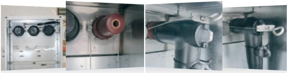
Exemple de raccordement via un connecteur CSD (PMD) 250 A sur cellule Interrupteurs Fusibles (IFA) :
