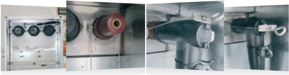
Exemple de raccordement via un connecteur séparable droit CSD (PMD) 250 A sur cellule Interrupteurs Fusibles (IFA) :
